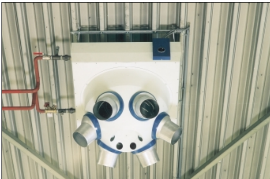
Figuur 4: De NOZ luchtverwarmer van Biddle.
