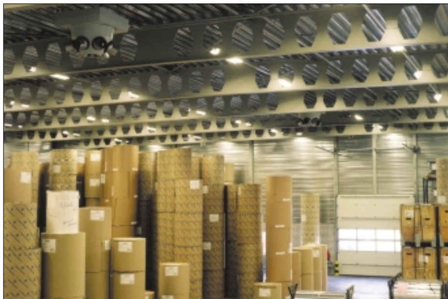
Figuur 3: De nozzles zorgen ervoor dat de warme lucht in de papieropslag goed wordt verdeeld.
