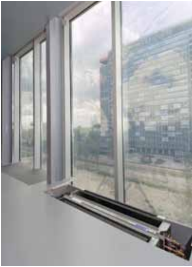
In de gevel van de TU Delft is de project-ventilatorconvector, model SL, toegepast.
