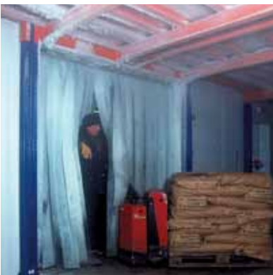
Strokengordijnen vormen een obstakel tijdens het transport.
