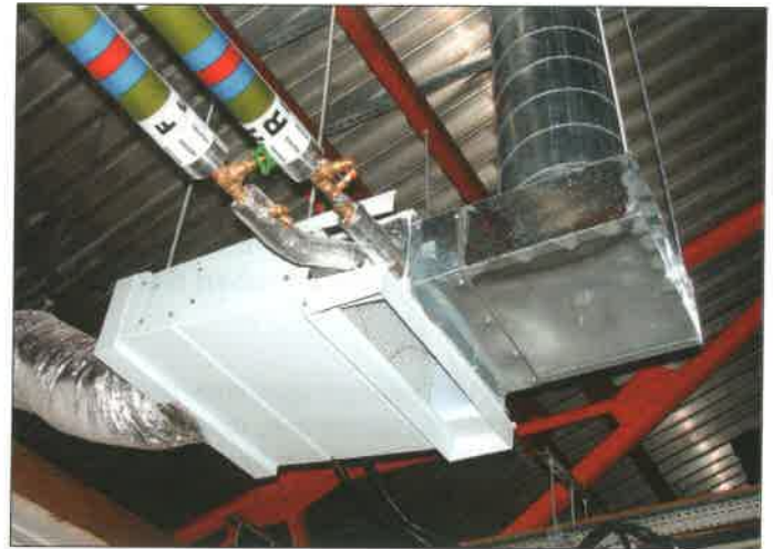
Deckeneinbaugerät für Montage in einem anderen Raum. Die über das Dach angesaugte Frischluft wird über eine Rohrleitung in den zu belüftenden Raum geführt.
