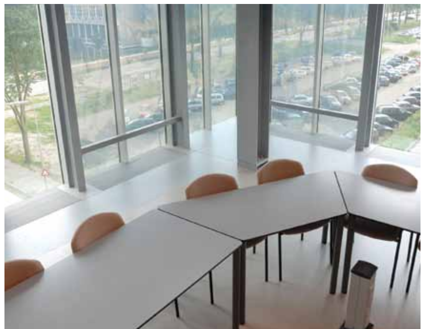
Kundenspezifische Klimälösung in der TU Delft (NL): Der SL ist im Boden montiert.
