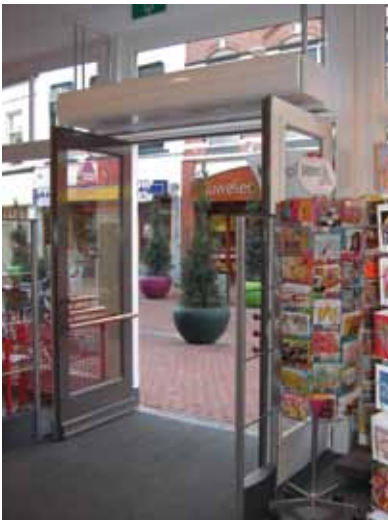
Der DoorFlow über der Türöffnung sorgt für ein zugluftfreies Innenklima.
